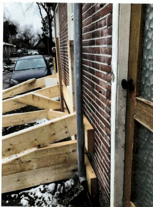
Foto 5: Samengestelde stut tegen onderzijde zijgevel.
