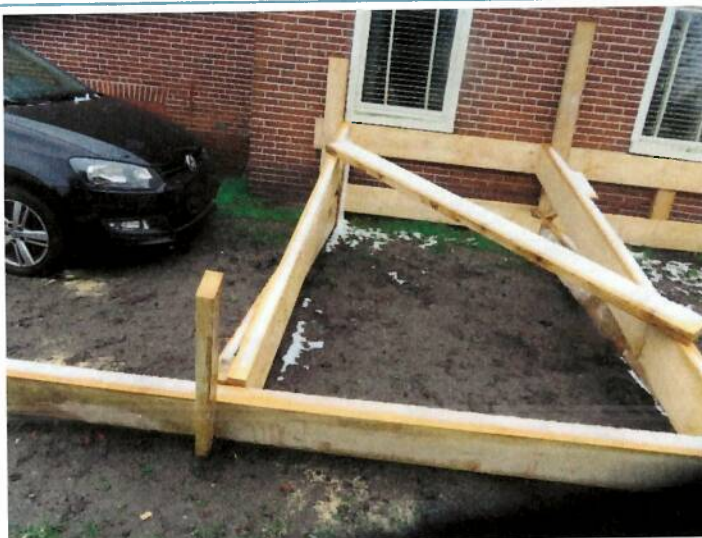
Foto 7: Samengestelde stut tegen onderzijde zijgevel.
