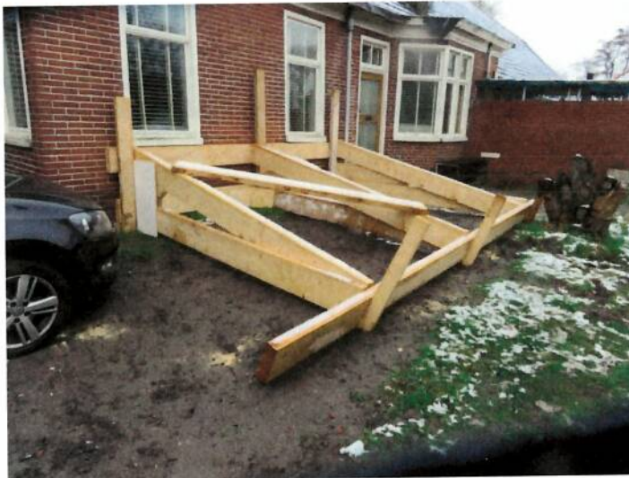
Foto 6: Samengestelde stut tegen onderzijde zijgevel.
