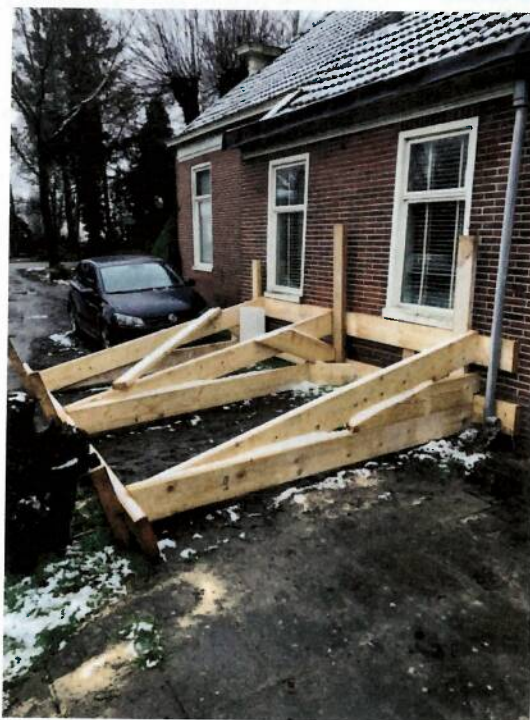
Foto 4: Samengestelde stut tegen onderzijde zijgevel.
