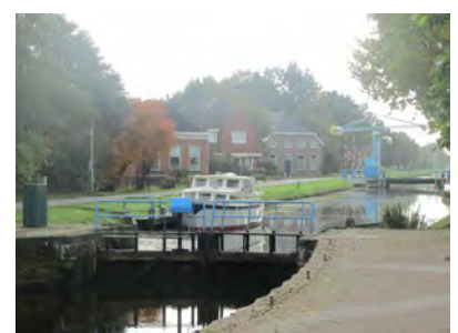
sluisje Dokter H. Brouwerstraat
