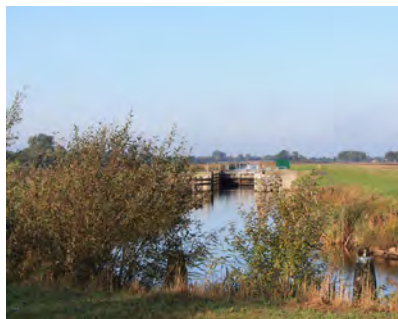
nieuwe sluis ontsluit zeilplas Langebosch
